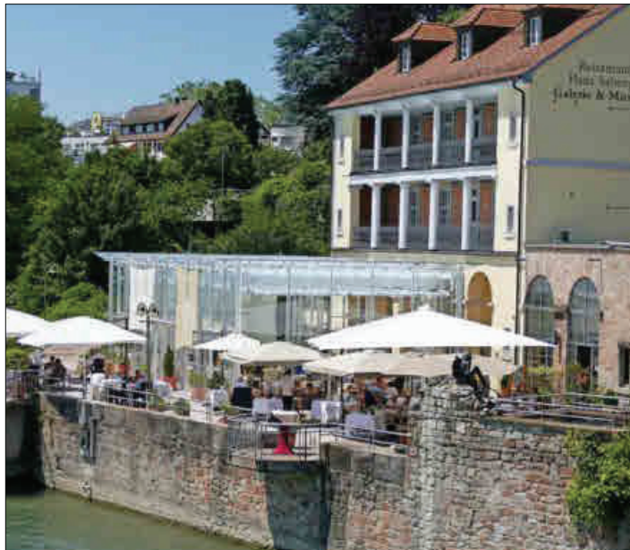
Zeitgemäß und modern mit neuem Wintergarten präsentiert sich das Haus Salmegg nach der Sanierung. VEP
